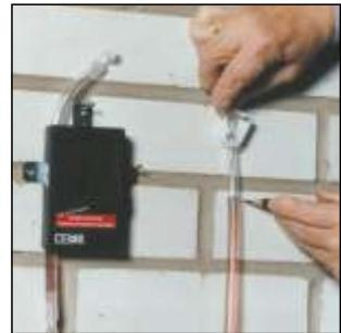
Не заполняйте шланг полностью, 30 см должны оставаться свободными. Подсоедините шланг к прибору. Включите электронику. Загорается контрольная лампа и сигнализирует о готовности к работе.
