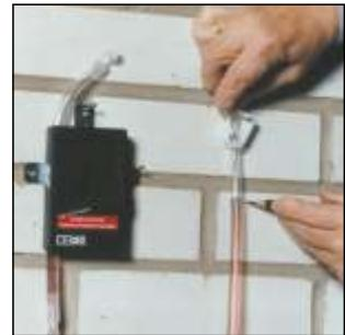
Füllen Sie den Schlauch nicht vollständig, 30 cm sollen frei bleiben. Verbinden Sie den Schlauch mit dem Gerät. Schalten Sie die Elektronik ein. Die Kontrolllampe leuchtet und zeigt die Betriebsbereitschaft an.
