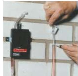
Vul de slang niet volledig, 30 cm moet vrij blijven. Sluit de slang aan op het apparaat. Schakel de elektronica in. Het controlelampje brandt en geeft aan dat het apparaat klaar is voor gebruik.
