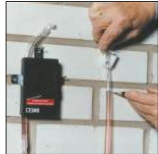
Ne remplissez pas complètement le tuyau, 30 cm doivent rester libres. Raccordez le tuyau à l'appareil. Allumez l'électronique. Le voyant de contrôle s'allume et indique que l'appareil est prêt à fonctionner.
